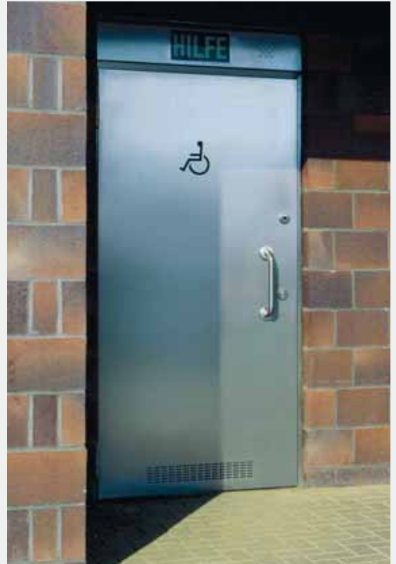
dw 51-1 „Teckentrup DF“ in Edelstahl, 240er Korn geschliffen.
