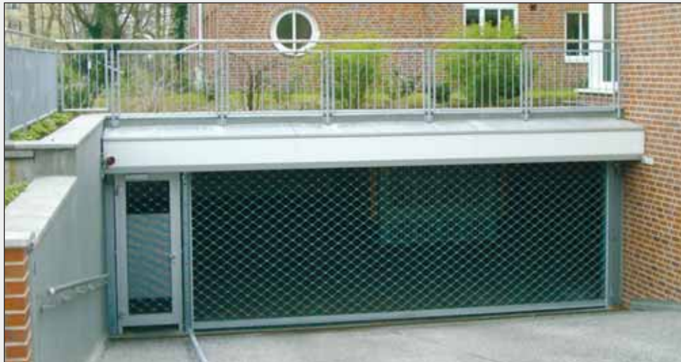
Rollgitter mit Nebentür in Tiefgarage.
