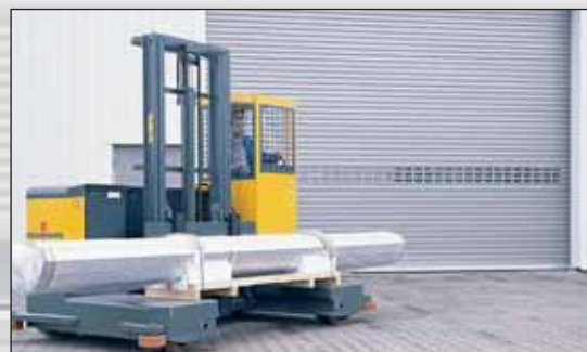
Der Rollpanzer kann so mit Hilfe eines Gabelstaplers auf die vormontierten Konsolen gesetzt werden.
