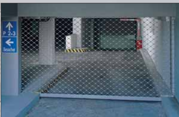
Schutz und Belüftung von Tiefgaragen.
